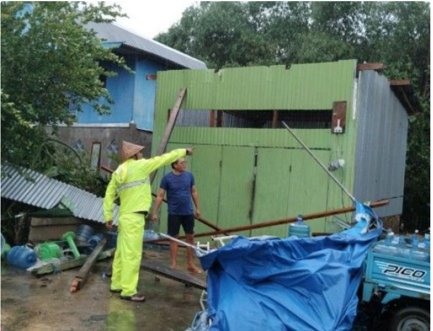
Cuaca Ekstrem, Puting Beliung Rusak Rumah Warga di Desa Kabba
